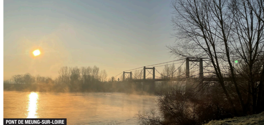
PONT DE MEUNG-SUR-LOIRE
