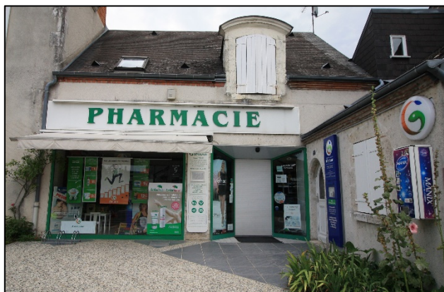
Panneaux d'enseignes – Rue Cyrille Fauchoux
